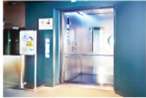
障害者向け 館内エレベーター設置
